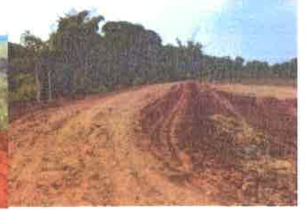
โครงการซ่อมแซมถนนลูกรัง หมู่
