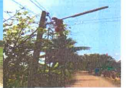
โครงการซ่อมแซมไฟฟ้าส่องสว่าง
