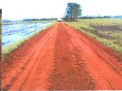
โครงการปรับปรุงถนนลูกรัง หมู่ 6
